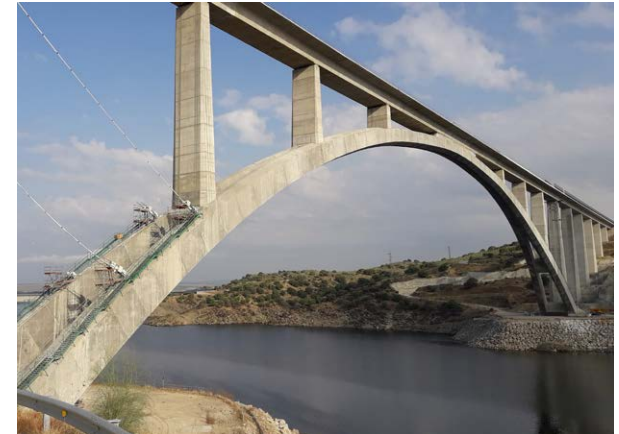
Viaducto de Almonte, Cáceres (España).
