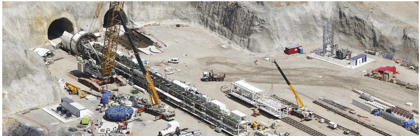
Túnel de Pajares (España)
