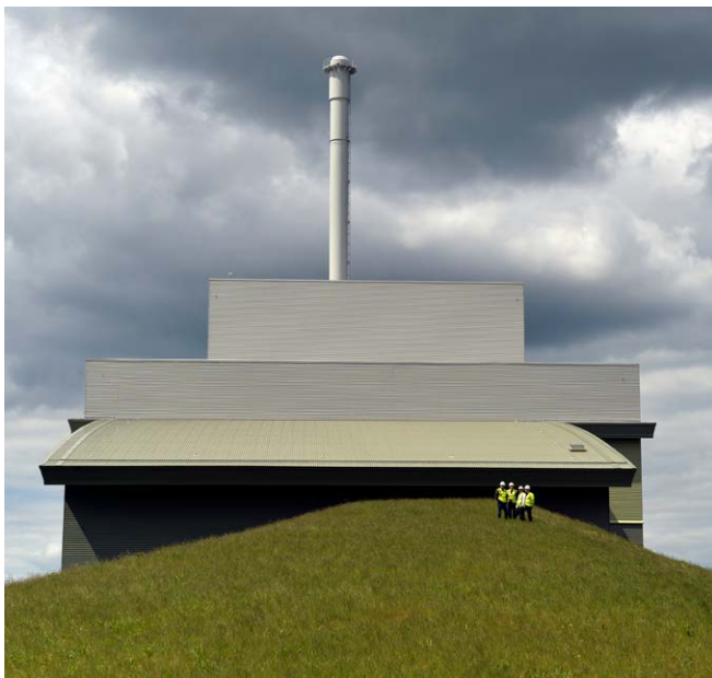
Planta de Valorización energética de residuos de Greatmoor, Reino Unido.
