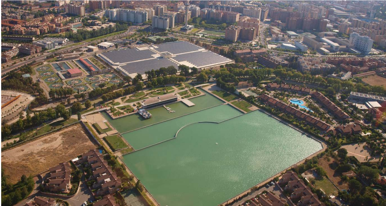
Depósitos de agua de Casablanca, Zaragoza. España
