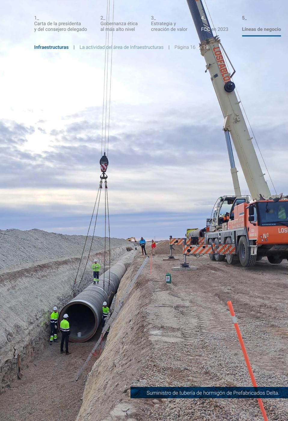
Suministro de tubería de hormigón de Prefabricados Delta.
