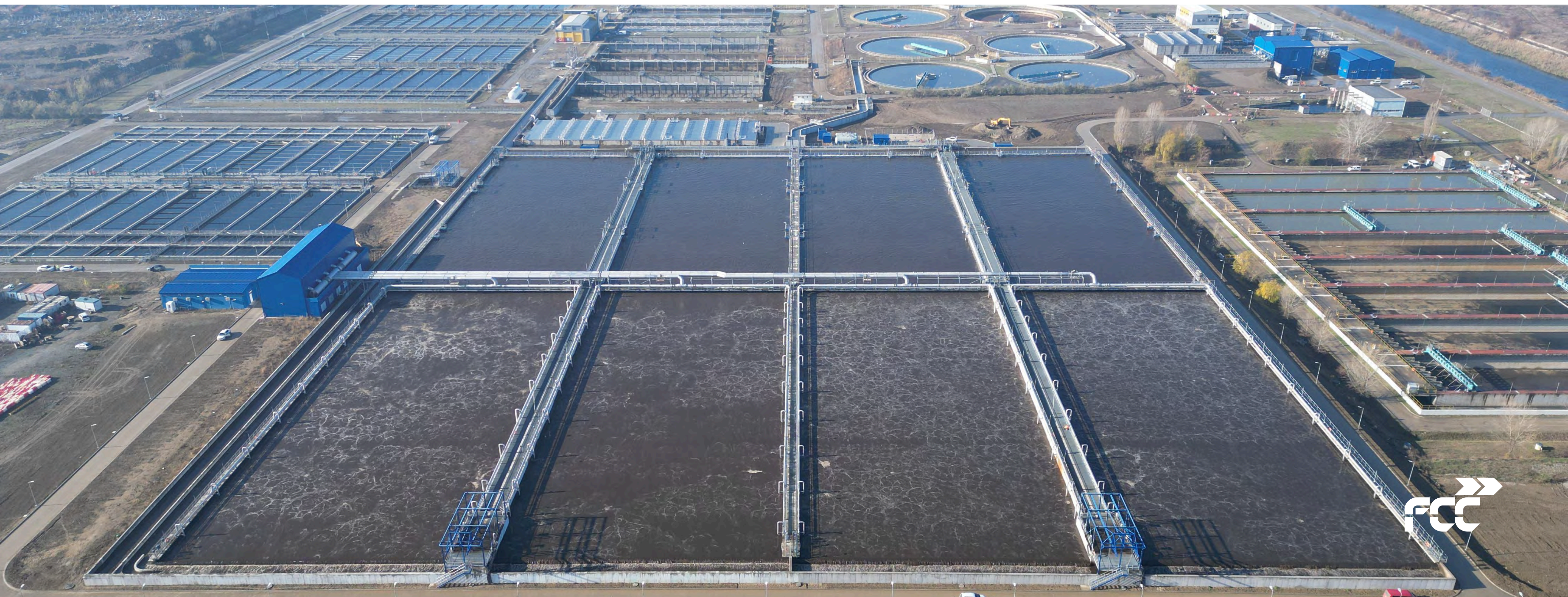
Planta depuradora de Glină, Rumanía
