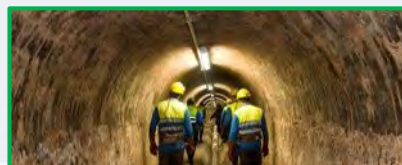
Mantenimiento del alcantarillado
