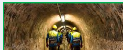
Mantenimiento del alcantarillado
